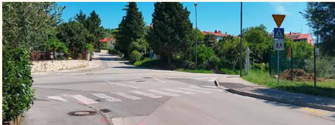
Križišče Liminjanske ceste in ulice Borcev NOB pred pričetkom izvedbe krožišča.
