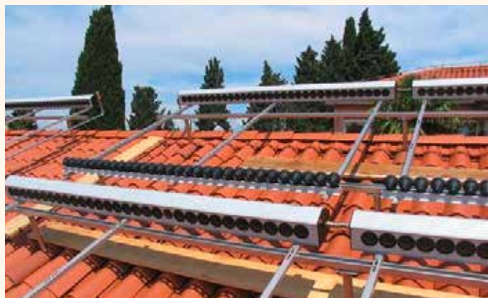
Nosilci za montažo vakuumskih sprejemnikov sončne energije.
